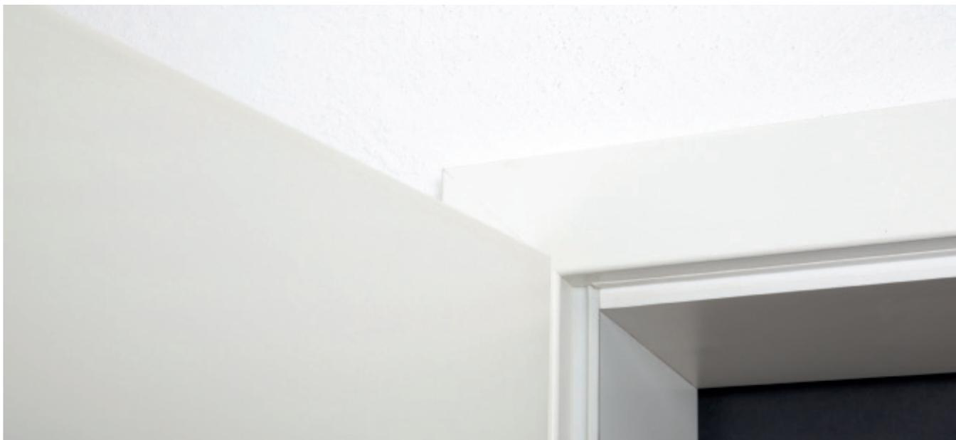
Mit der ÜSD wird das Thema Wohnungslüftung und Verbrennungsluftversorgung ganzheitlich betrachtet. Eine ÜSD wird statt der standardmäßigen Systemdichtung in die Aufnahmenut der Holz-Türzarge eingesetzt. Sie ermöglicht innerhalb der Wohnung das Überströ-
