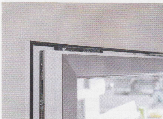
Der Fensterfalzlüfter ist in der Dichtungsnut des Flügels eingeclipst. Er ist auch bei offenem Fenster quasi nicht sichtbar
