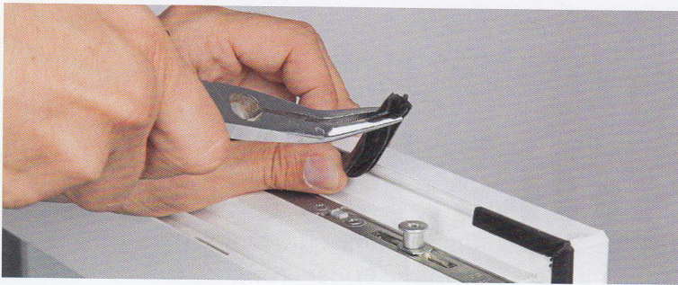
Schritt 1: Entfernen Sie die Flügelüberschlagsdichtung.
