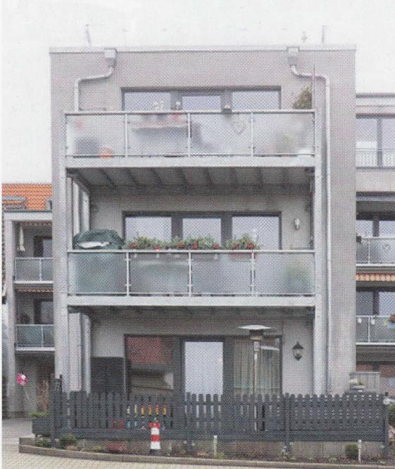
Für ein langes Fassadenleben: Auf die hofseitige Gebäudehülle wurde ein Wärme-dämm-Verbundsystem aufgebracht
