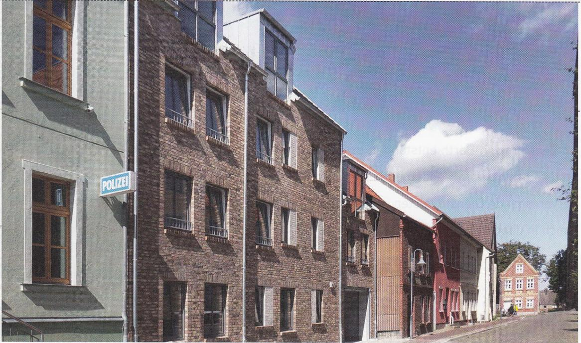
Der Massivbau gefällt straßenseits durch eine vorgemauerte Ziegelsteinfassade
